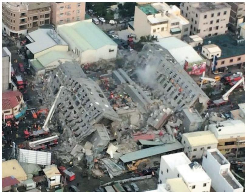
部呈「U」字型，屬於住商混合大樓，約有90多戶近200多人居住，大樓面向西，地震當時由西向東傾斜，接著倒向永大路上，三分之一樓體在地面，接近三分之二樓體下陷或損毀。
