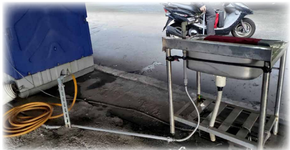
STEP5 完成標準洗手台安裝，輕輕鬆鬆可使用潔淨水源
