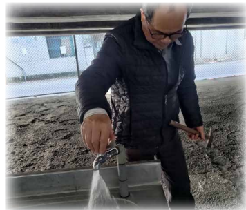
STEP4 設置洗手台固定座
