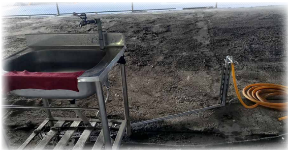
STEP4 設置洗手台固定座
