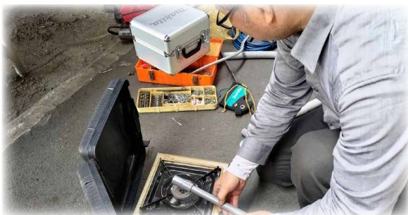
STEP2 火烤軟化將接縫處銜接
