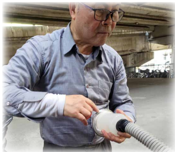
STEP3 水槽集水管固定
